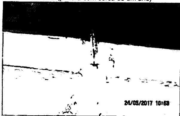
Foto 2 – Sinais de infiltração junto ao forro, descolamento da tinta (pintura com cerca de um ano)
