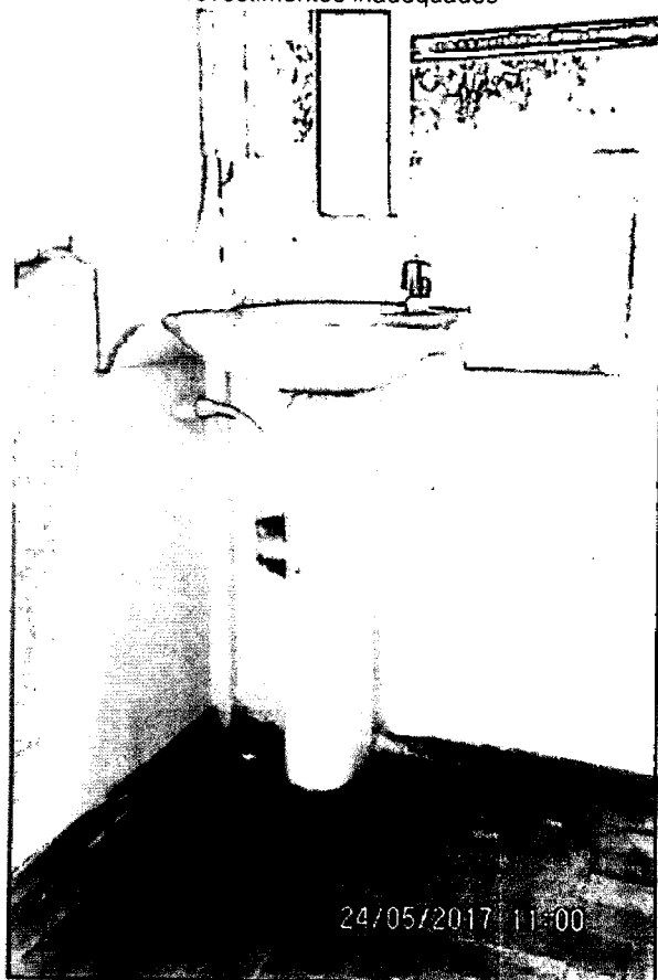
Foto 5 – Piso com umidade e eflorescência e revestimentos inadequados
