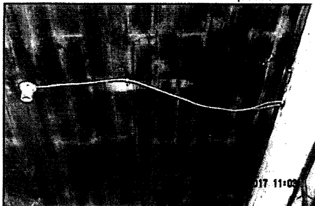
Foto 6 – Luminária inadequada, fios paralelos expostos e com emendas e isolamentos inadequados
