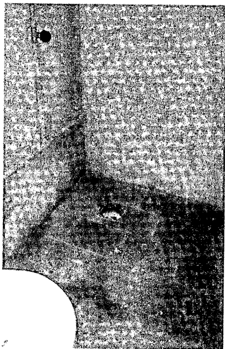
RACHADURA EM VERGA ENTRE O PAVILHÃO DOIS E O PAVIL. HUM.
