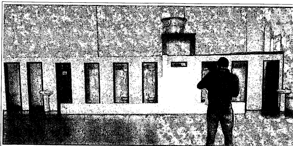
VISTA GERAL DOS BOXES SANITÁRIOS DO PAVILHÃO HUM.
